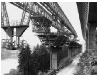
engins de levage
