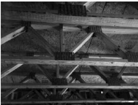
Nœud d'une ferme (assemblage Gangnail)
